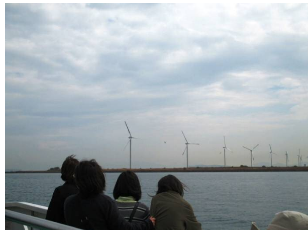
「エヌエスウインドパワーひびき」の風力発電施設
