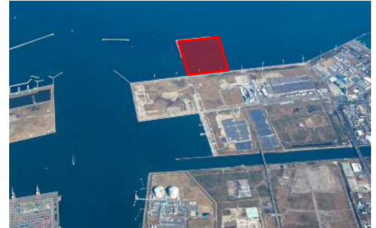
処分場整備箇所
